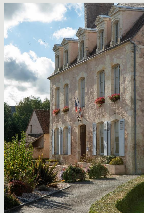
La Mairie : la maison de tous les Cetonnais
